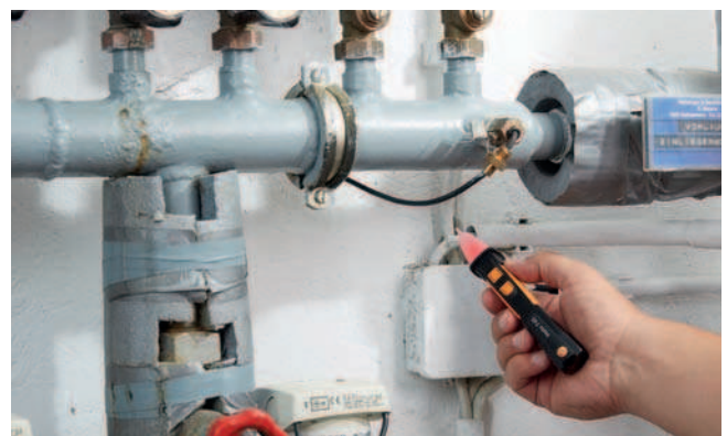
Проверка питания в распределительном щитке с testo 745
