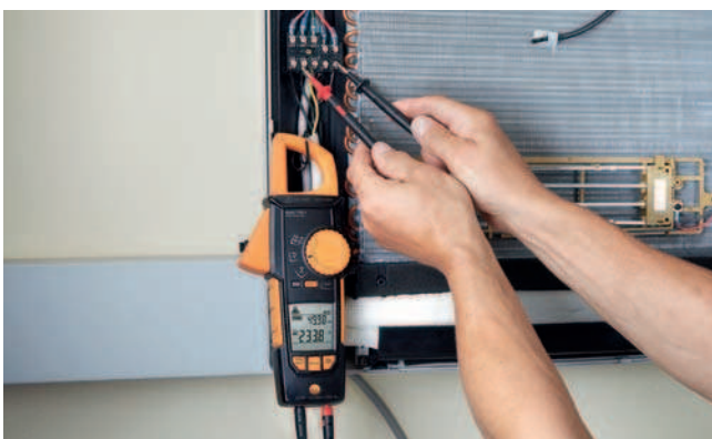
Измерение напряжения на блоке кондиционера с testo 770
