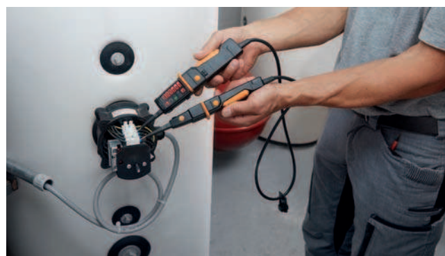
Измерение напряжения на бойлере
