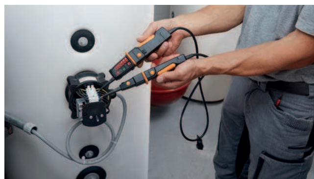
Измерение напряжения на бойлере
