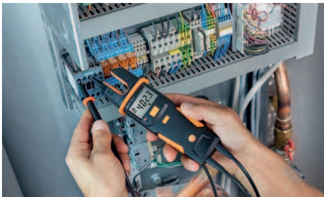
Проверка напряжения на тепловом насосе с testo 755
