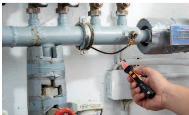
Проверка питания в распределительном щитке с testo 745
